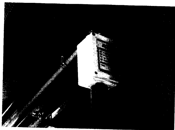
Fig. 10 – centralina segnalazione fuga gas
