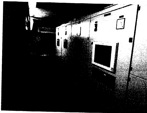
Fig. 15 - quadro elettrico generale
