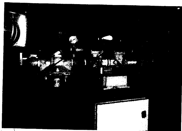
Fig. 3 - rampa gas interna
