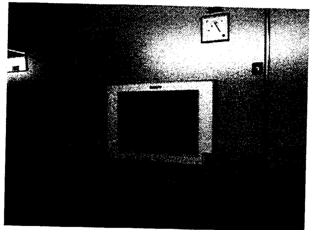
Fig. 16 – schermo di supervisione impianto
